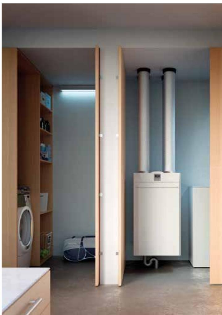
**Toutes les unités sont équipées d'un système de by-pass automatique** qui permet l'exclusion totale de l'échangeur de récupération, afin de permettre le **free-cooling** (ou le free-heating) à 100 %.
