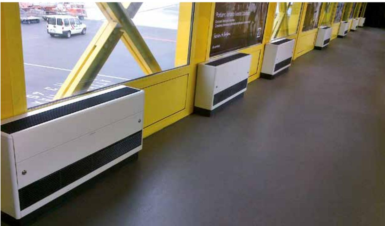
**Carrosserie d'habillage** : elle est réalisée en tôle d'acier galvanisée, prépeinte en RAL 9002 (gris clair), d'une épaisseur de 1,2 mm et équipée de serrures à clef pour sécuriser l'ouverture du panneau frontal.
