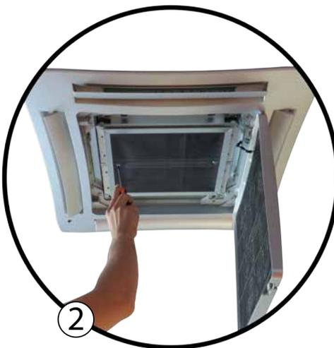
À ce stade, le filtre Crystall est facilement accessible (3). Le châssis du porte-filtre peut se débloquer en retirant la vis de fixation appropriée et peut être ouvert afin de permettre l'extraction des filtres Crystall en aluminium (4).
